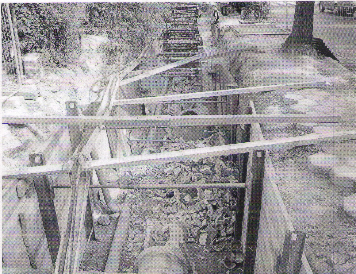
Rys. 1. Remont sieci kanalizacyjnej w ciągu chodnika
