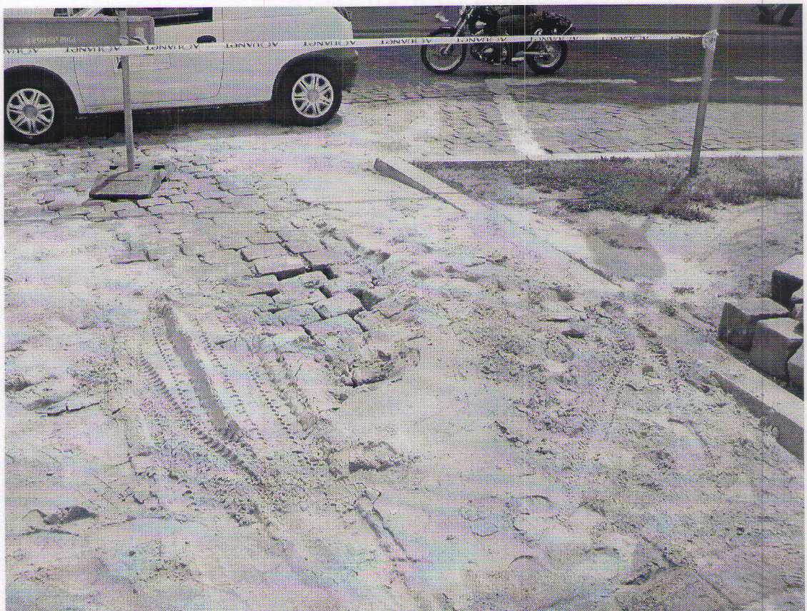
Rys. 8. Przykład zapadnięcia nawierzchni z kostki kamiennej w wyniku awarii sieci wodociągowej
