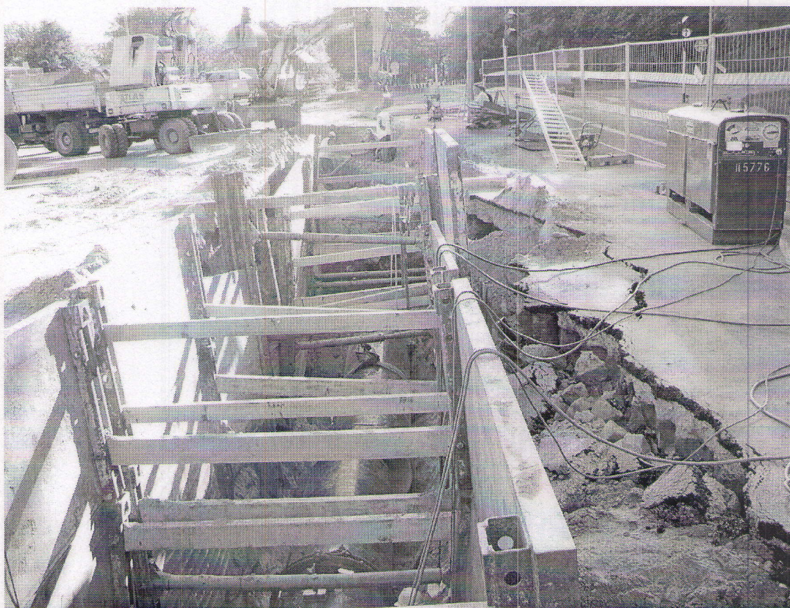
Rys. 2. Degradacja nawierzchni w pobliżu wykopu
